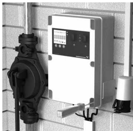
Fig. 8 Montage du régulateur LC 221
